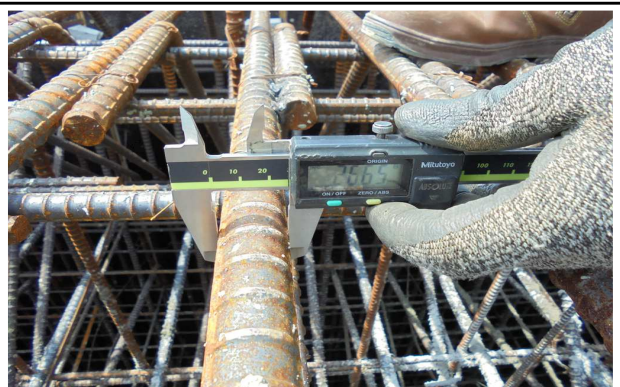
철근 배근 현황
