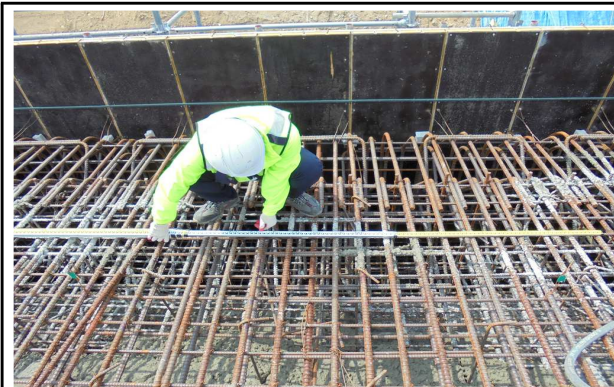
철근 배근 현황
