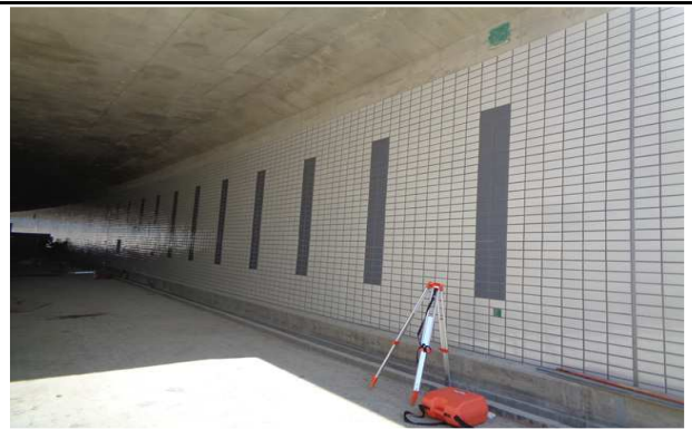
측벽 타일 전경
